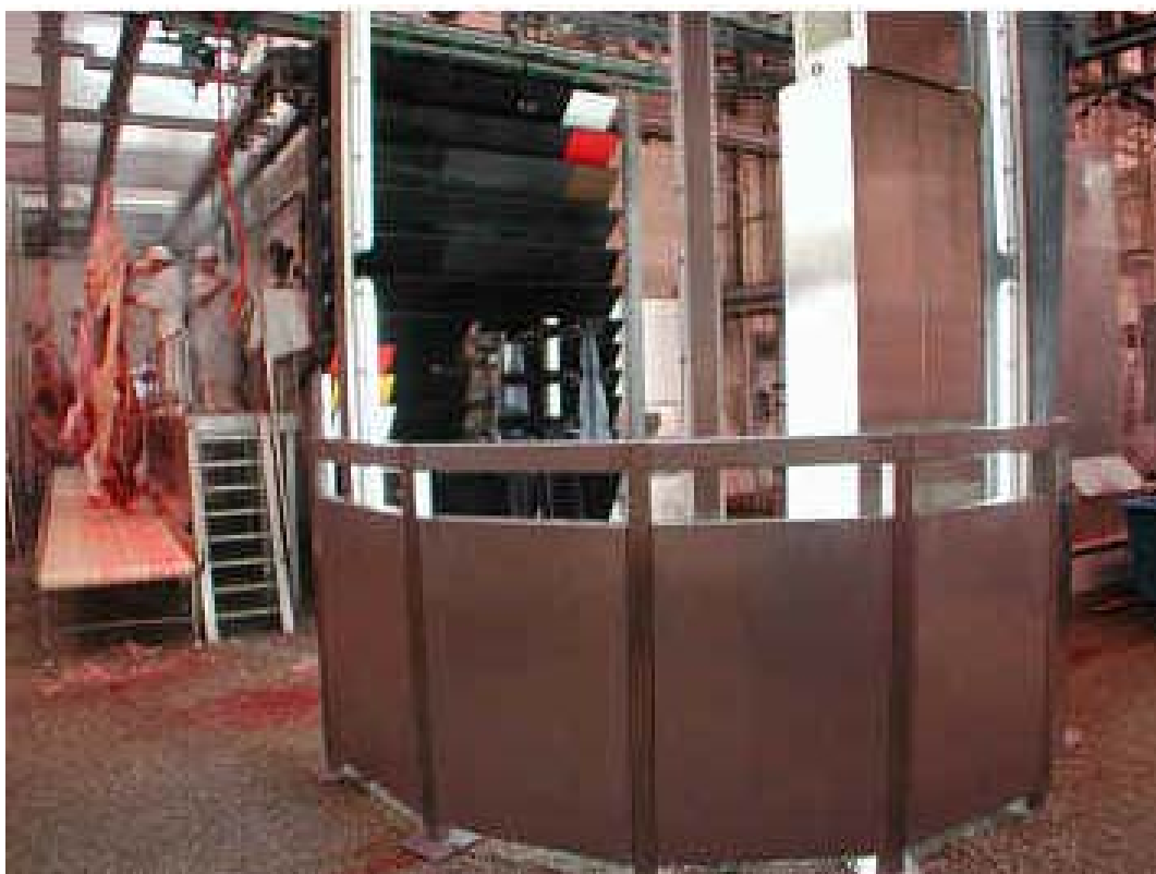
Photo 4 : Machine à classer installée avec barrières de protection (source : NormaClass)
