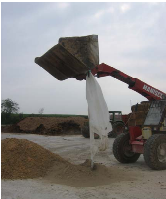
Disposition de la chaux à proximité immédiate du tas de déchets
