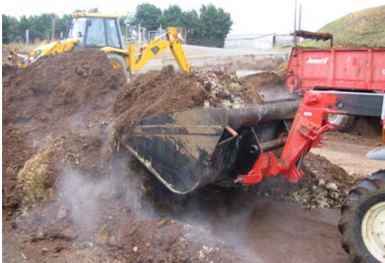
Au moment de la reprise du tas constitué avant J0, on note un dégagement de vapeur indiquant que les fermentations ont déjà commencé
