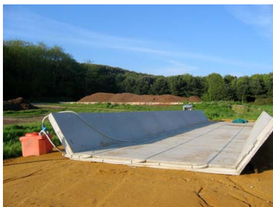
Vu du silo avant son remplissage
